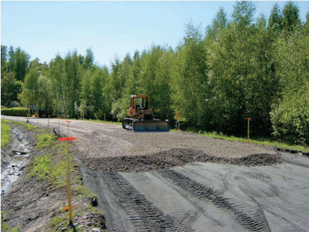
Kuva 40. Betonimurske kadun kantavassa kerroksessa.
