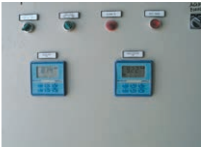
Kierrätysveden pH:n säätö ja mittaustulokset ohjauspaneelissa
