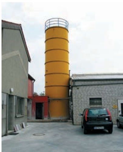
Pystyselkeyttimen torni
