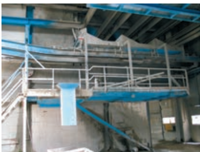
Betoninkuljetusjärj. sukkulan pesupaikka
