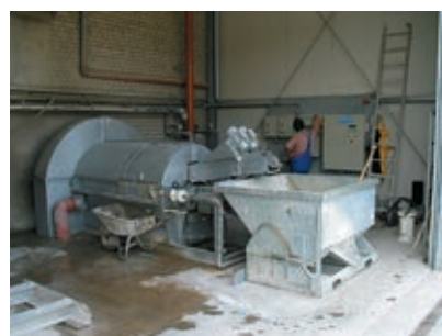
Pesuri ja kiviaineksen kuljetustastia. Laitteiston ohjauskeskus taustalla.
