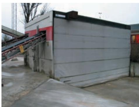
Kiviainestasku ja suotopuristimen suoja-rakennus
