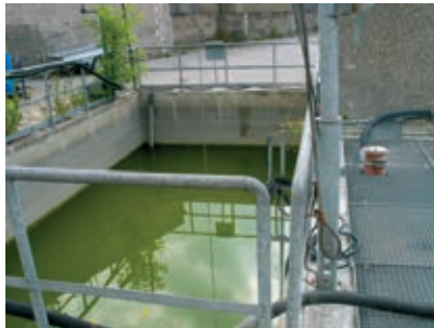
Vasemmalla sadevesiallas, oikealla slurryallas.
