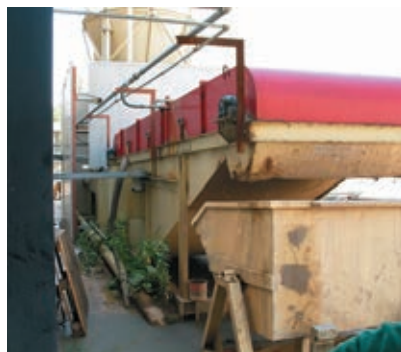
Pesuri (karkean kiviaineksen erottelu)
