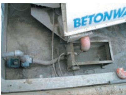
Slurryn pumppaus altaaseen
