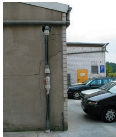
Lieteputkiston liittimet, sadevesien keräyskourut
