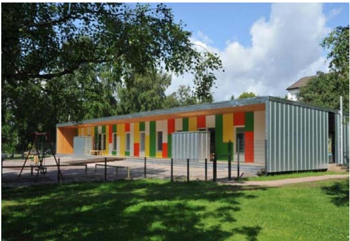
2008 valmistunut paviljonkipäiväkotä Silkkiuikku Helsingin Lauttasaassa on siirrettäväksi suunniteltu 11 tilaelementistä koostuva rakennus. Tämän ja kuuden muun kaupungin tilaaman tilaelementtipäiväkodin arkkitehti on Seppo Häkli.
