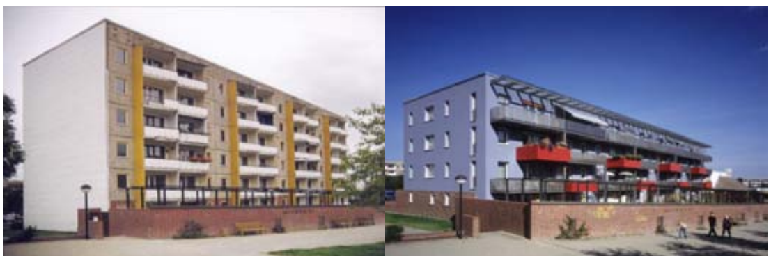
Büchnerstraße 18-40. Valmistunut 2001. Kustannukset 704 €/m 2 .
