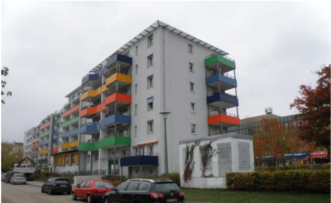
Entinen Ringkolonnaden Westseite, nykyinen Seniorenzentrum Polimar.
