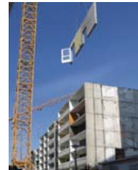
Betonielementtien irrotus ehjänä uudelleenkäyttöön on teknisesti mahdollista.
