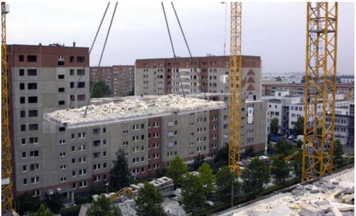
Välipohjaelementtien purkamista ehjänä Berliinissä. Taustalla näkyy tyypillisiä WBS70-tyypin 11-kerroksisia asuinrakennuksia. (Asam).
