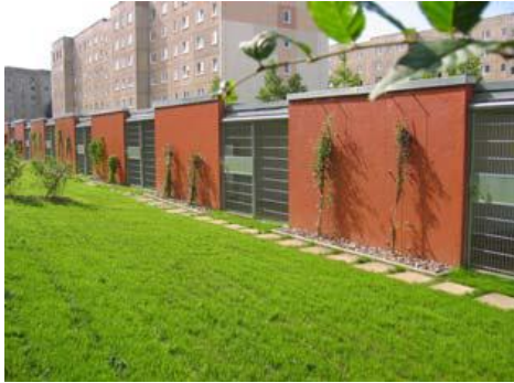
AUTOKATOKSET WALTERSHAUSEN, SAKSA
