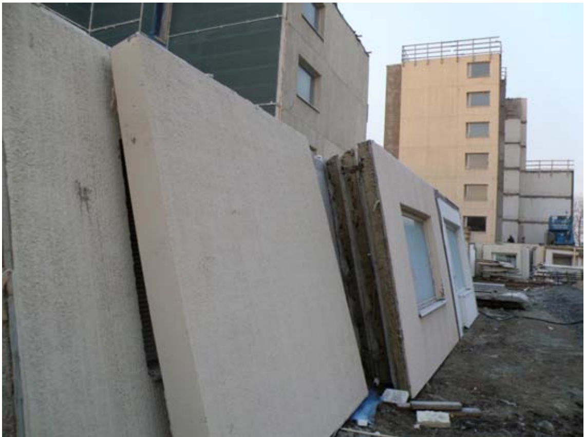
Kokonaisina purettuja ulkoseinäelementtejä Kummatissa joulukuussa 2009. Elementit olivat harjattupintaisia ja puukkokannatettuja, ja säilyivät hyvin ehjinä irrotuksessa.
