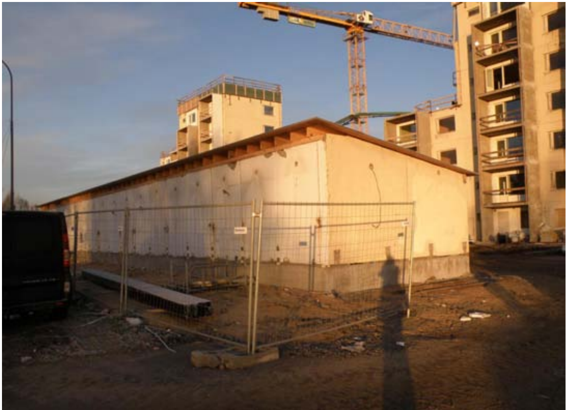
Uudelleenkäytetyistä elementeistä rakennetun autokatoksen runko vielä verhoilemattomana joulukuussa 2009.
