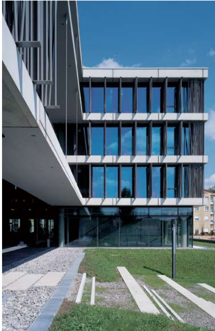
Sairaskassa Schwenninger BKK:n hallintorakennuksen lasijulkisivu aurinkosuojineen.
