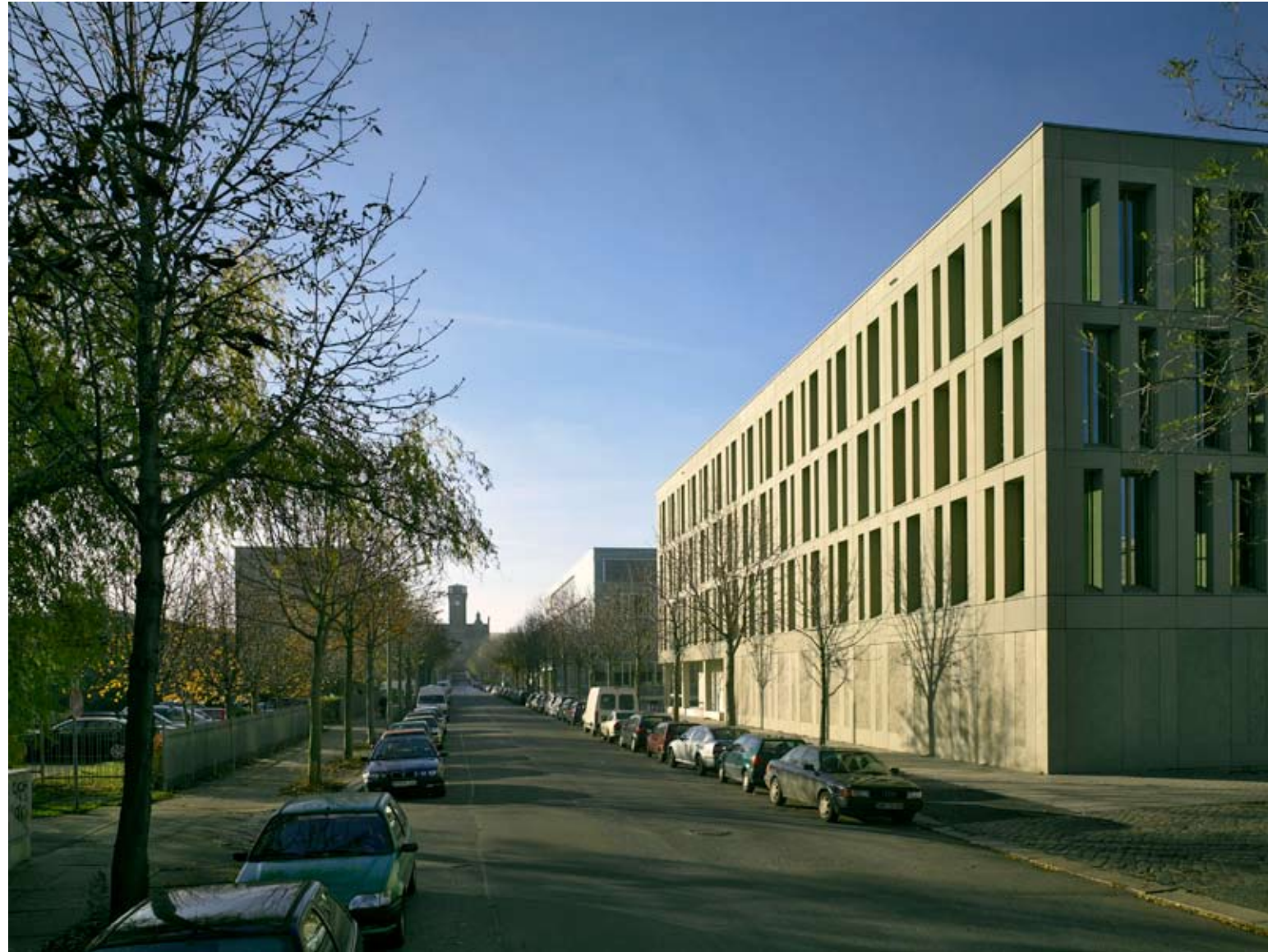
Dresdenin teknillistaloudellisen ammattikorkeakoulun kirjaston energiaratkaisuna on käytetty mm. aktivoitua betoniydintä.
