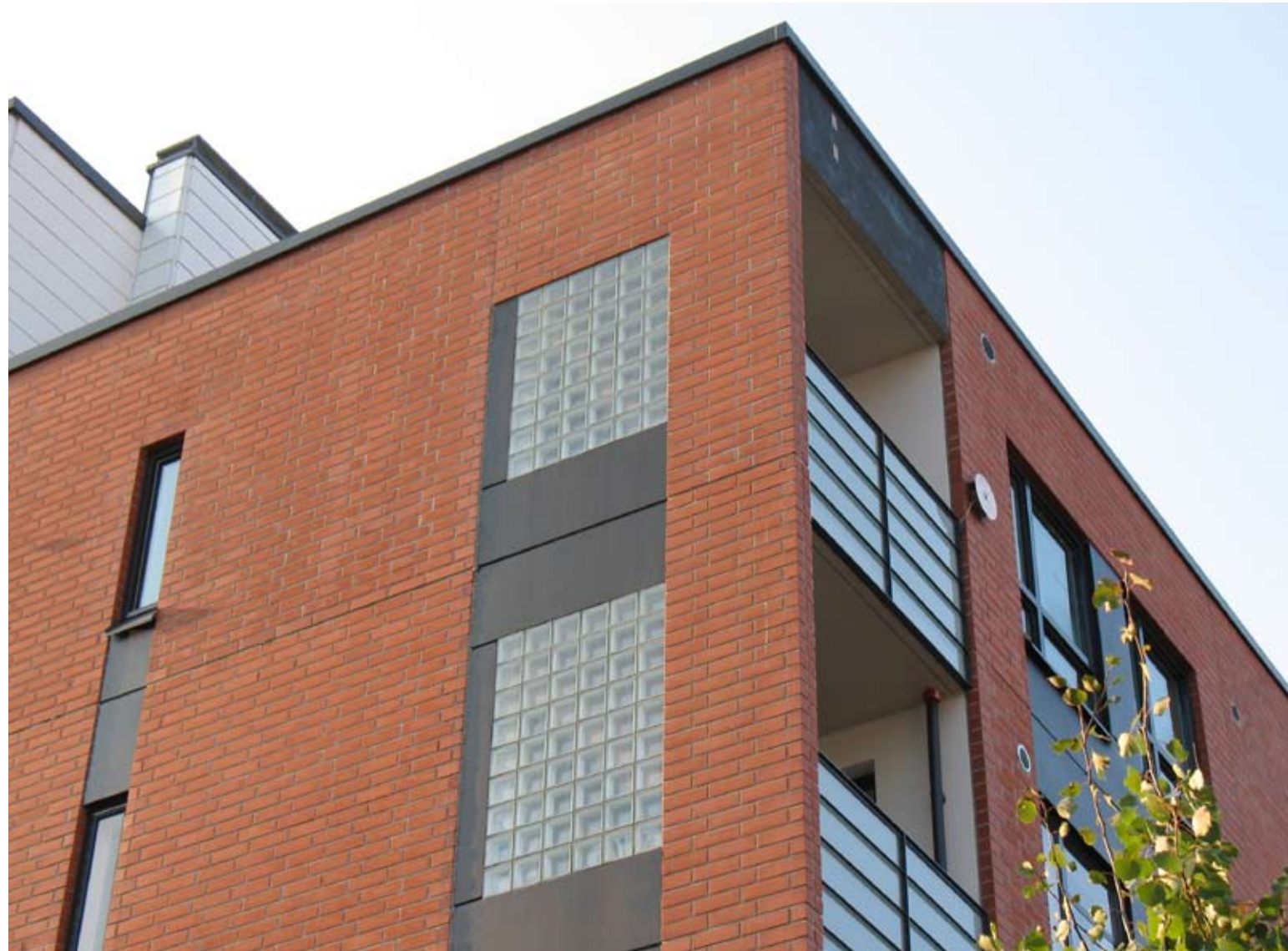
Rakennusliike Reponen on kehittänyt oman MeraReponen-matalaenergiakerrostalokonseptinsa. Ensimmäinen sen mukainen kerrostalo valmistui Heinolaan huhtikuussa 2009.
