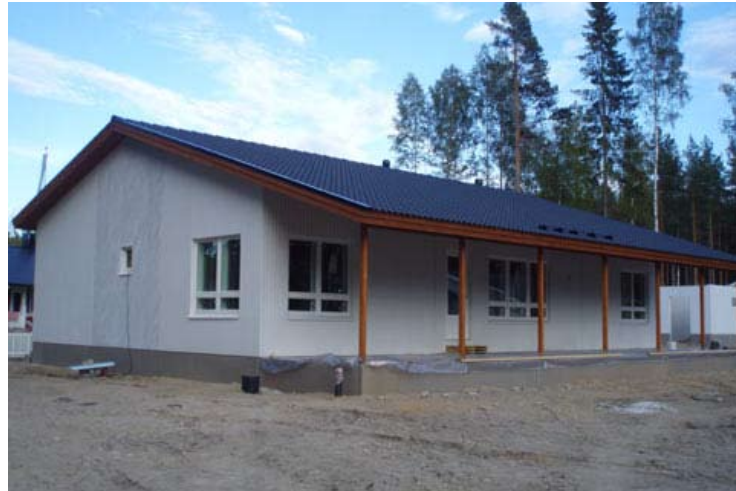
Tiivis betonielementeistä tehty passiivitalo (VTT:n mitaama ilmanvuotoluku n_{50} = 0,09 ). Suutarinen- Yhtiöt.
