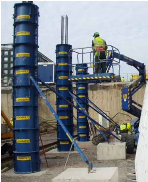
Kuva 13. Henkilönostimen käyttö muottityössä.
