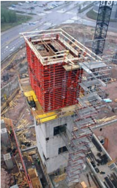
Kuva 5. Kulkureitti järjestetty erillisen telineen kautta.
