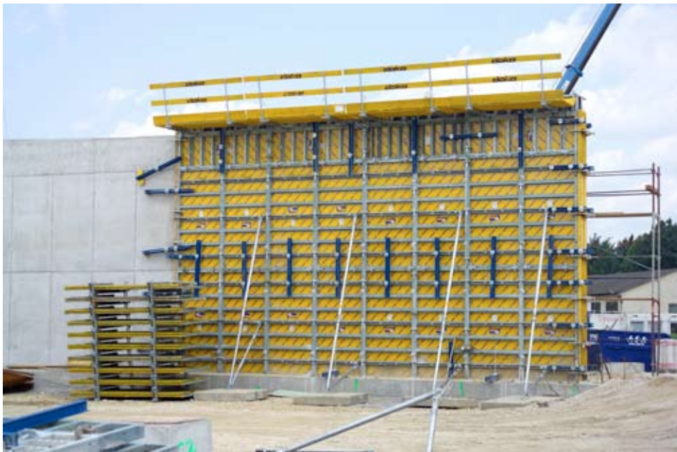
Kuva 8. Muottiin kiinnitetty työtaso ja kaide.
