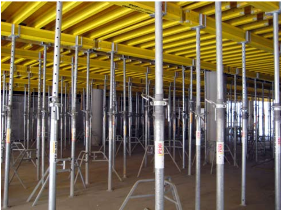
Kuva 11. Vaakamuottien pystytuet tuettu asennustuilla.
