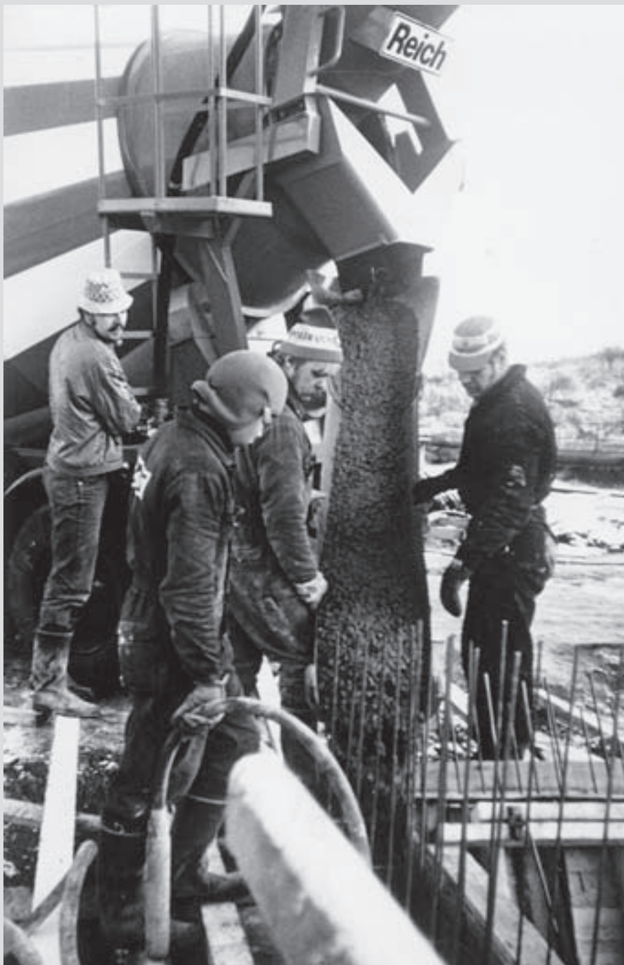
Hyvinkään Betonin allassäiliöautot vaihtuivat 1980-luvun puolivälin tienoilla kuvan pyörintäsäiliöautoiksi. Valmisbetoni valutetaan ränniä pitkin suoraan paikallavalukohteeseen. Itse valu on rakennusurakoitsijan vastuulla betonitoimittajan vastuun ulottuessa betonin toimittamiseen työmaalle.
