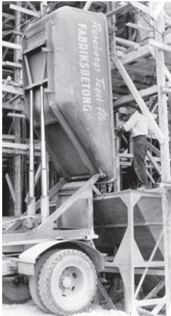
Betonia kuljetettiin pitkään työmaille allassäiliöautoilla, jotka kippasivat betonin työmaan vastaanottiin. Kuvassa Räseporin Tiilen betoniauto purkaa lastiaan 1960-luvun alkupuolella Swema-vastaanottiin, jonka tilavuus oli 2,5–3 kuutiometriä.
