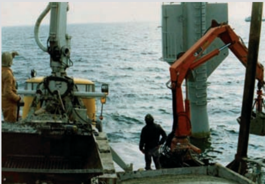
Valmisbetonia toimitettiin 1980-luvulla myös merialueiden valukohteisiin. Kuvassa betonipumppausta tielaitoksen valukohteessa Turun saaristossa.
