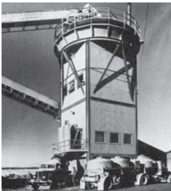
Heinäkuussa 1958 käynnistynyt Taivalsaa- ren valmis- betonitehdas koneistoinen oli tanskalaisten toimittama. Valmisbetoni kuljetettiin työ- maille allassäiliöautoilla ja tehtaan tarvitsema sementti tuotiin Lohjalta kuvan oikeas- sa alakulmassa olevilla irtosementti- autoilla.
