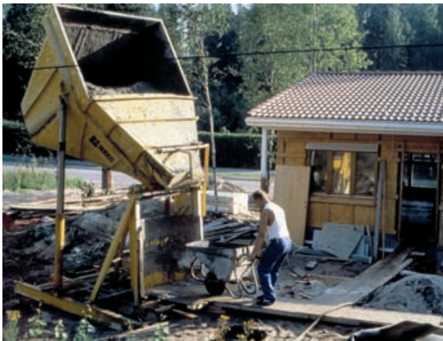
Pientalotyömailla on käytössä kuvien kaltaisia valutapoja. Ylemmässä kuvassa pyörintäsäiliöauto purkaa betonia ränniä pitkin suoraan valukohteeseen. Alemmassa kuvassa betoni on purettu vastaanottotaskuun, josta sitä siirretään betonikärryillä valukohteeseen kulloisenkin tarpeen mukaan.
