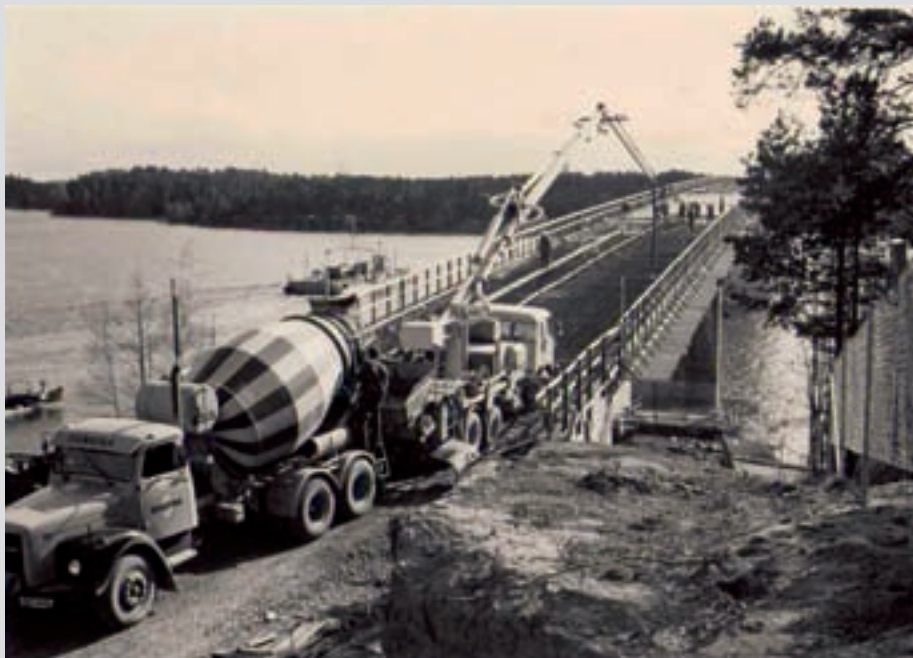
Semeran pyörintäsäiliöauto on tuonut betonikuorman ja yhtiön betonipumppuauto pumppaa betonia siltapilarin vedenalaiseseen valuun vuonna 1982. Tässä Kaitaisten sillan valussa betonia pumpattiin ensin vaakasuoraan 250 metriä ja vielä pystysuoraan veden alle 16 metriä.
