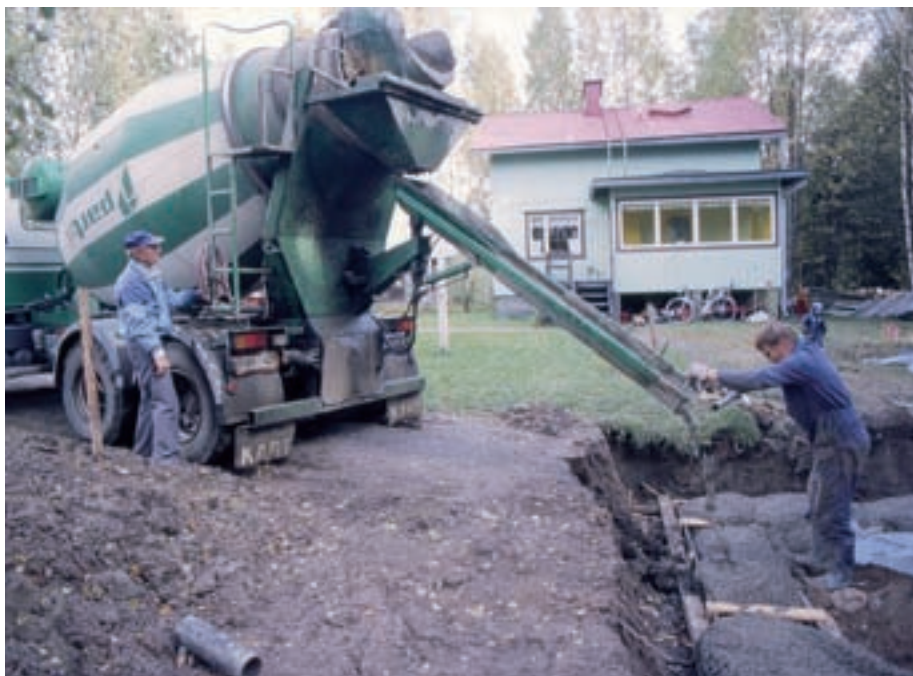
Pientalotyömailla on käytössä kuvien kaltaisia valutapoja. Ylemmässä kuvassa pyörintäsäiliöauto purkaa betonia ränniä pitkin suoraan valukohteeseen. Alemmassa kuvassa betoni on purettu vastaanottotaskuun, josta sitä siirretään betonikärryillä valukohteeseen kulloisenkin tarpeen mukaan.
