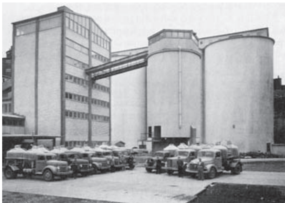
Parainen uudisti vuonna 1956 Sörnäisten tehtaita, jonne sementti kuljetettiin laivoilla ja edelleen maakunnan kaupunkeihin rakennettuihin sementtisiiloihin kuvan irtosementtiautoilla. Valmisbetonin tuotanto alkoi Sörnäisten tehtailla vuonna 1958.
