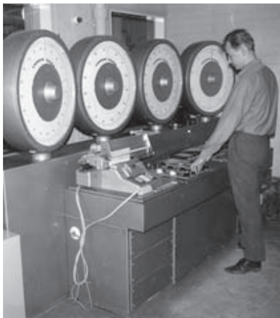
Suuret valmisbetonitoimittajat pystyivät hankkimaan tehtaisiinsa aikansa parasta teknologiaa ja valmistuslaitteistoja. Kuvassa Partekin Veronmiehenkylän tehtaan ohjauspöytä, jonka ääressä betoni-mylläri pikkukengissä valmistaa betonierää.
