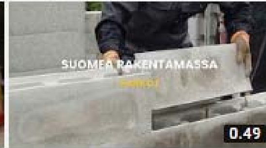
Suomea rakentamassa: Harkot
