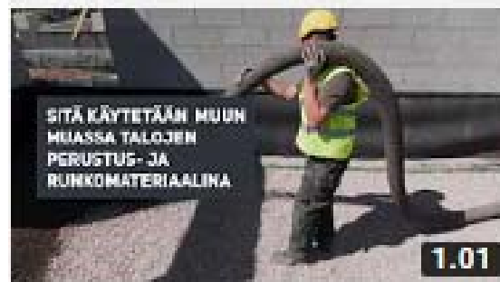
Suomea rakentamassa: Kevytsora
