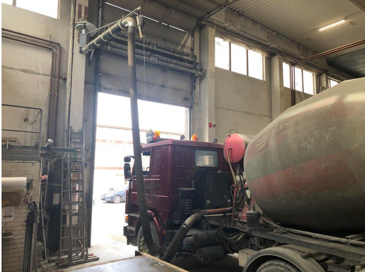
Kuva: Rudus Oy, Savonlinna. Tehdashallissa pakokaasunpoistojärjestelmä käytössä betoniautoa varten.
