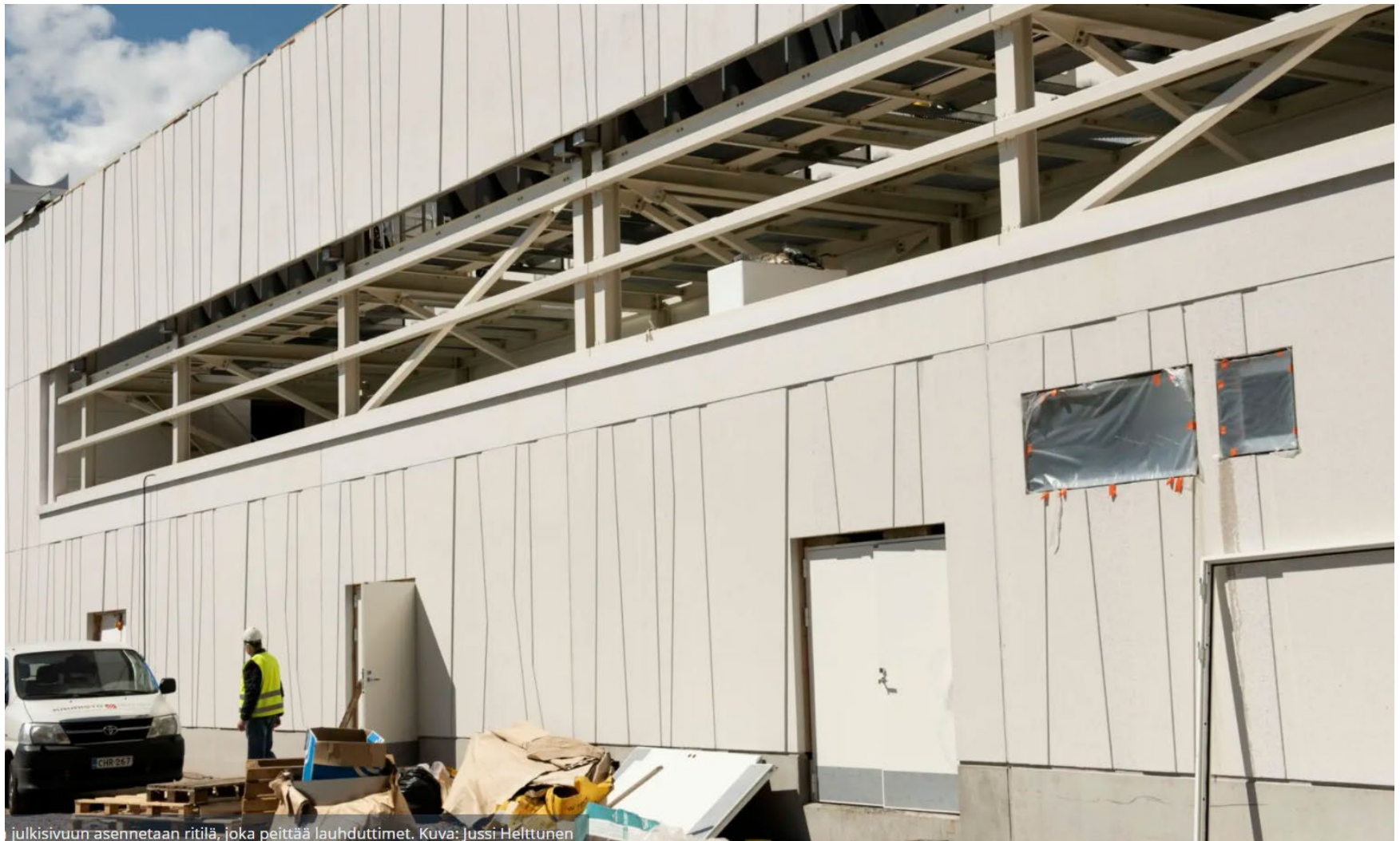
julkisivuun asennetaan ritilä, joka peittää lauhduttimet. Kuva: Jussi Helttunen
