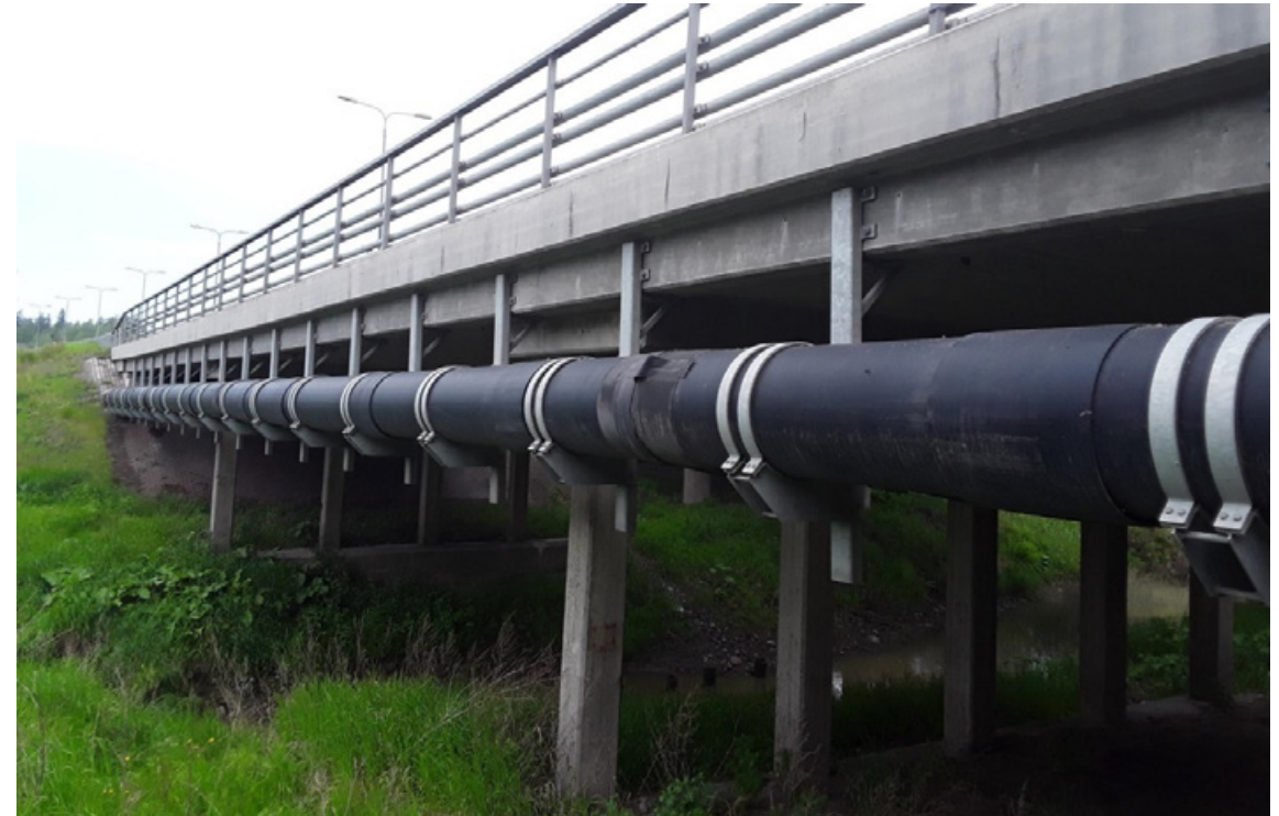
Lähde: T-178 Vähäjoen silta - Taitorakennerekisteri
