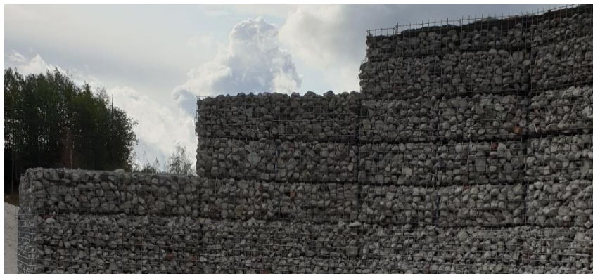
Kuva 1: Meluvallina toimiva kivihäkki valmistettuna kierrätysbetonimurskeesta Ruduksen kierrätyspisteellä.
