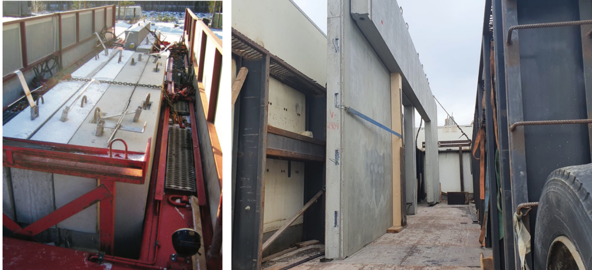
Vasemmassa kuvassa elementit varmistettu kampaan tukemalla ja sitomalla ketjuilla. Oikealla olevassa kuvassa esimerkki suunnittelijan määrittämästä kirveskiven kuljetustuesta.
