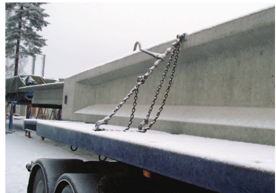
Kuva 5. Poikittaissuuntainen vinosidonta kuormassa olevista sidontapisteistä kohtisuoraan kuormaa kohden sivuille liukumisen ja kaatumisen estämiseksi. Sidontavälineet sijoitetaan symmetrisesti kappaleen painopisteen ympärille samassa pystysuuntaisessa sidontakulmassa. Mikäli kuvan mukaisessa sidonnassa sidontakulma on yli 60°, käytetään sidontatarpeen määrittämiseksi ylisidonnalle laskettuja taulukkoja (Taulukko 1 - Taulukko 3).
