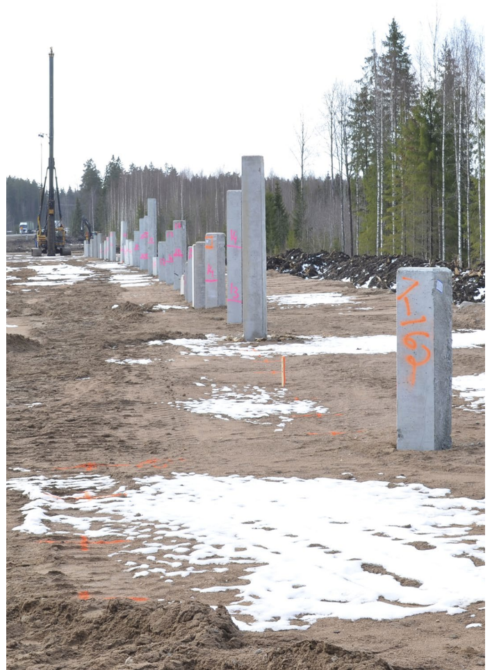
Kuva 4. Teräsbetonipaalujen pituuden vaihtelua paalulaatalla. Kuva: Väylävirasto
