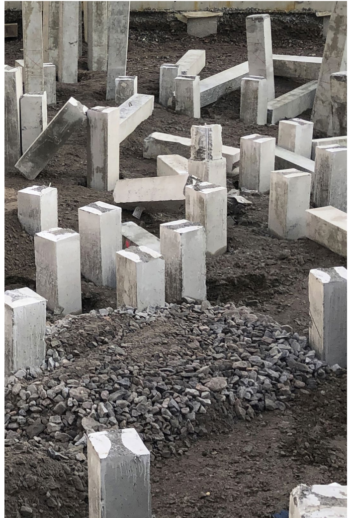
Kuva 5. Katkaistuja teräsbetonipaaluja.
