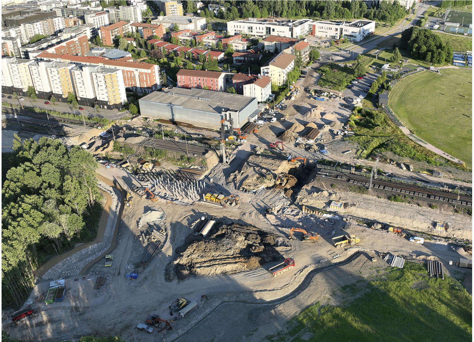
Kuva 6. Teräsbetonipaalulaatta ratatyömaalla, jossa käynnissä useita samanaikaisia työvaiheita.
