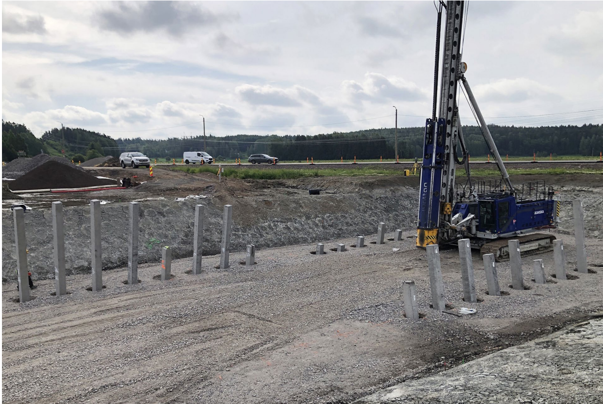
Kuva 8. Vinopaaluja asennettuna työmaalla, jossa koneella on riittävät työtilat.
