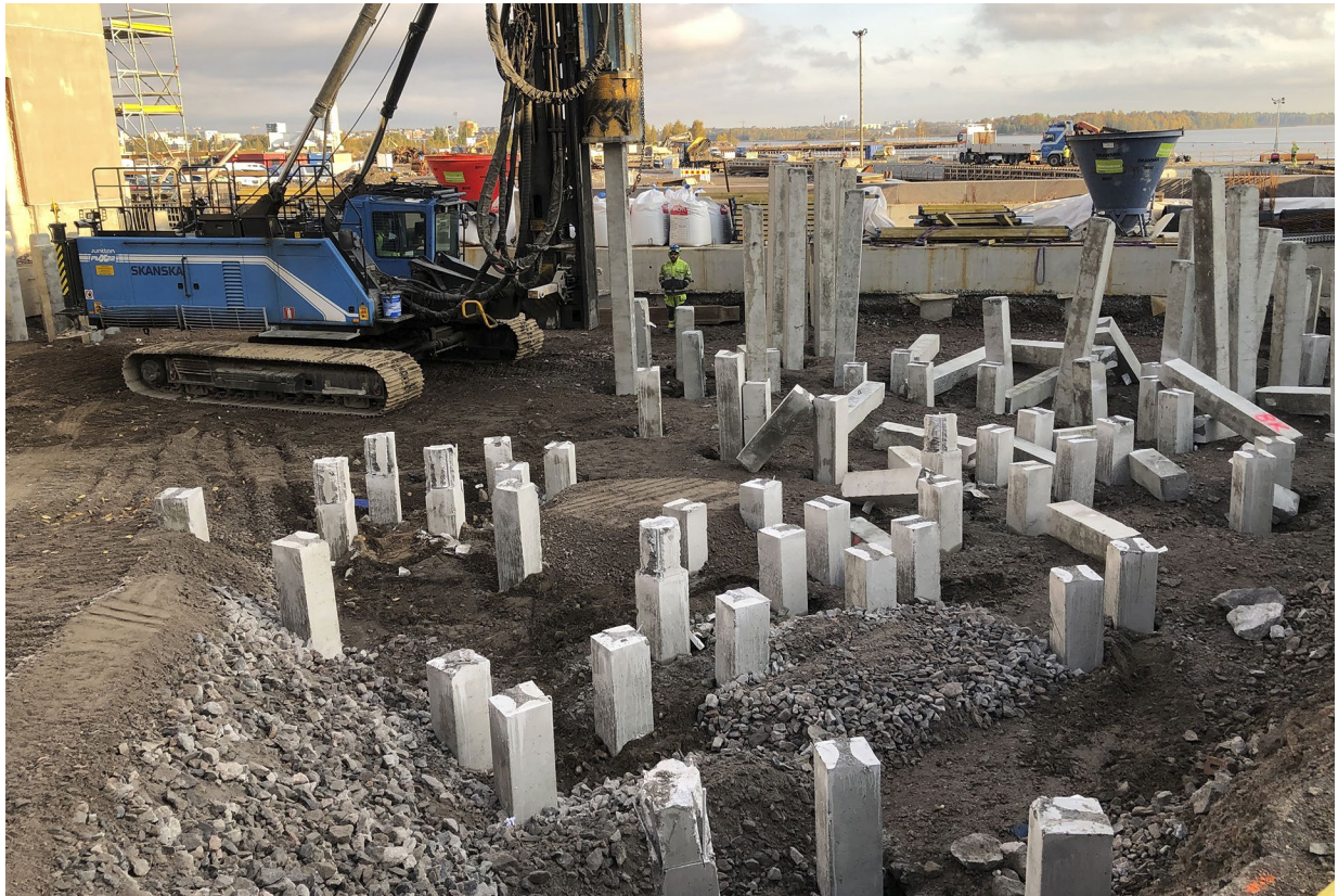
Kuva 10. Katkaistuja paaluja ja teräksien paljastuksia ahtaissa työmaaolosuhteissa.
